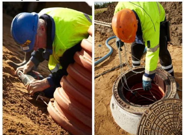
Kapa förhöjningen och gör en genomföring för nivåarmets kablage. Det utförs lämpligen innan betäckningen monteras. Håll koll på hur mycket betäckningens ram bygger nedåt inuti förhöjningen! Om tät toplösning önskas så montera en invändig tättningsring överst i röret.
