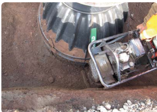
Komprimering med maskin
