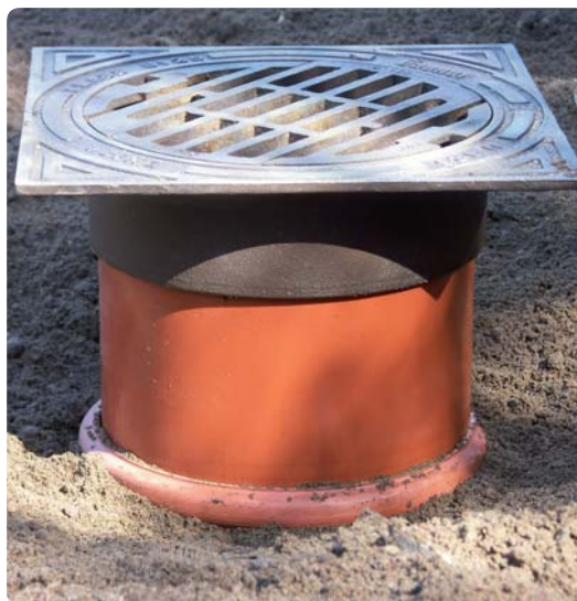
5. Stryk på smörjmedel på teleskoprörets spetsända och montera den invändigt i brunnsröret. Fyll upp och packa till önskad nivå.
