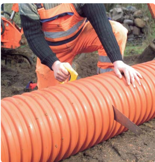
6. Det korrugerade brunnsröret i PP går lätt att kapa till önskad längd med en fogsvans.
