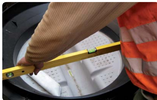
Kontroll av installation
