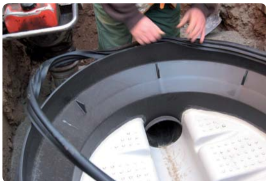
Montering av rör
