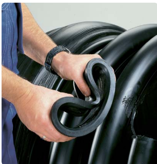
2. Anborningsmanschetten monteras.
