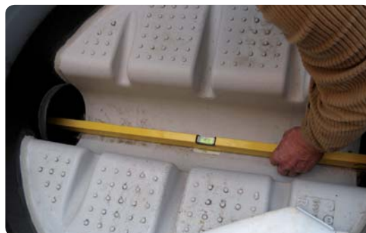
Kontroll av fall
