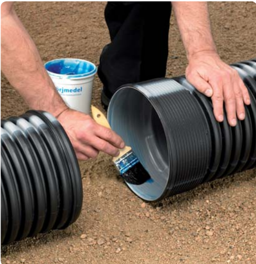
3. Muffen smörjs invändigt med smörjmedel.
