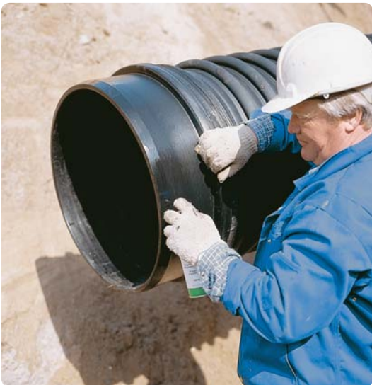
3. Stryk smörjmedel på rörets spetsända.
