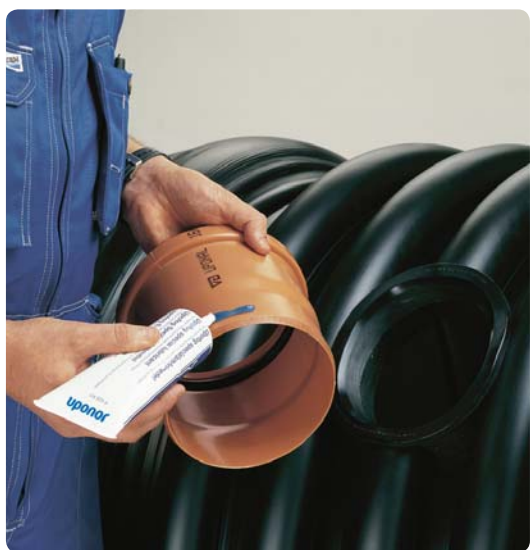
3. Stryk smörjmedel på anslutningsrörets spetsända
