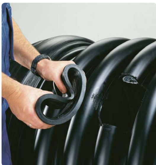
2. Manschetten monteras
