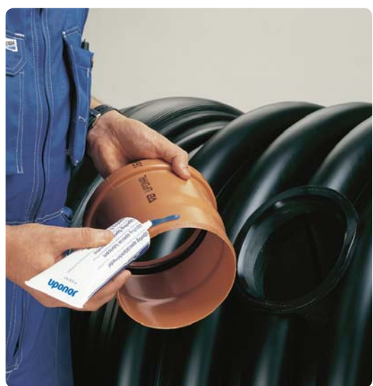
3. Stryk smörjmedel på anslutningsrörets spetsända
