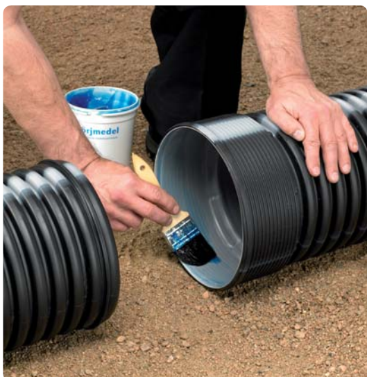
3. Muffen smörjs invändigt med smörjmedel.
