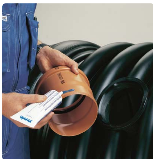
3. Stryk smörjmedel på anslutningsrörets spetsända
