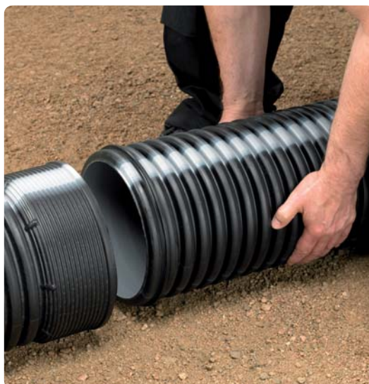
2. För tätt rörsystem monteras tätningsringen som sätts i första spåret från spetsändan.
