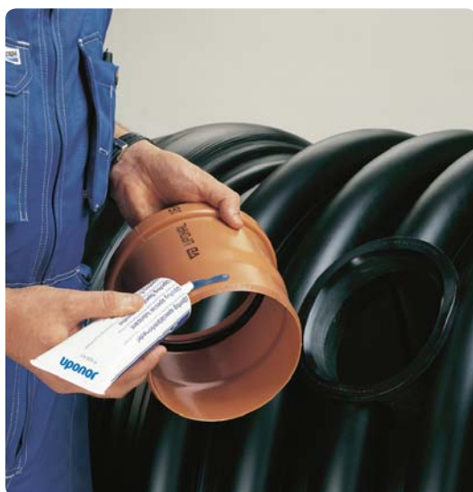
3. Stryk smörjmedel på anslutningsrörets spetsända
