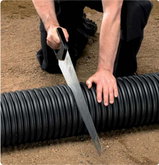
1. Röret sågas av mellan 2 ribbor med fogsvans.
