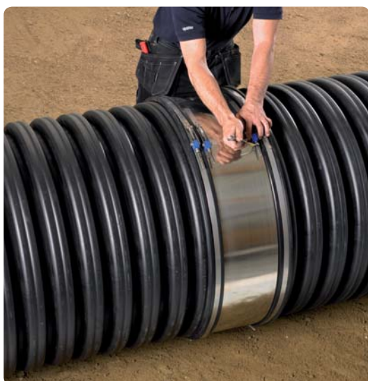
3. Montera det breda stålbandet runt i det mittersta spåret på gummiprofilen. Montera sedan de smala stålbanden. Dra först åt de smala stålbanden och sedan det breda.
