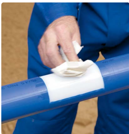
4. Röret torkas av med rengöringsvätska före svetsning.
