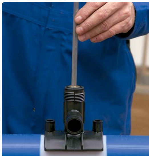
8. Efter avslutad svetsning och avsvälning kan man anborra med anborrningsverktyget. Det går att anborra med tryck i röret.
