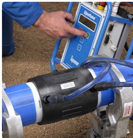
8. Därefter utförs elektrosvetsning.
