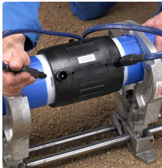
6. Montera svetskablar, och muffen är klar för svetsning.
