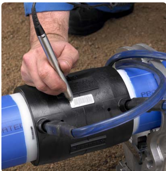
7. Avläs svetsdata med hjälp av streckkodssystemet.
