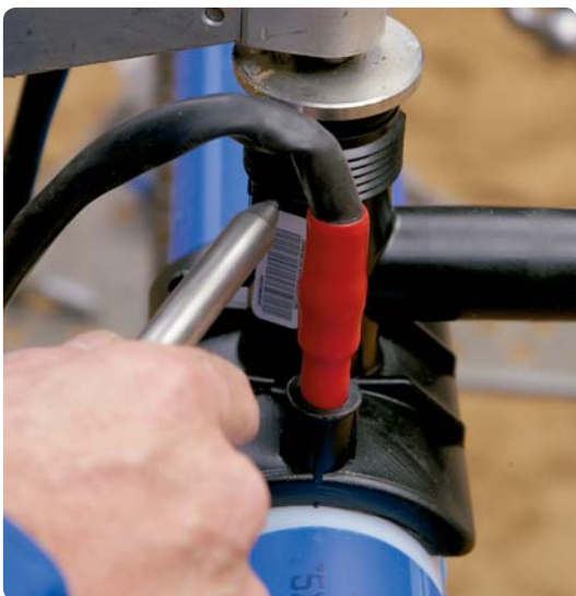
7. Därefter utförs elektrosvetsning.
