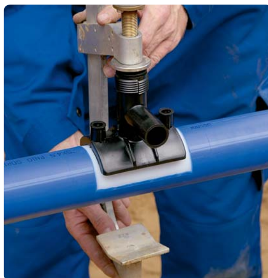
5. Fäst rördelen på Profuse-röret med hållverkyget.
