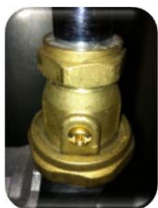
Avstängningsventil Stängt läge.
